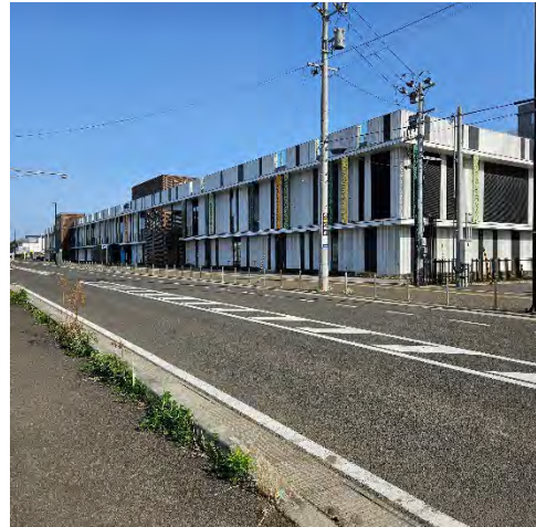
Fig. 36 Photographie de la station de métro Arai
