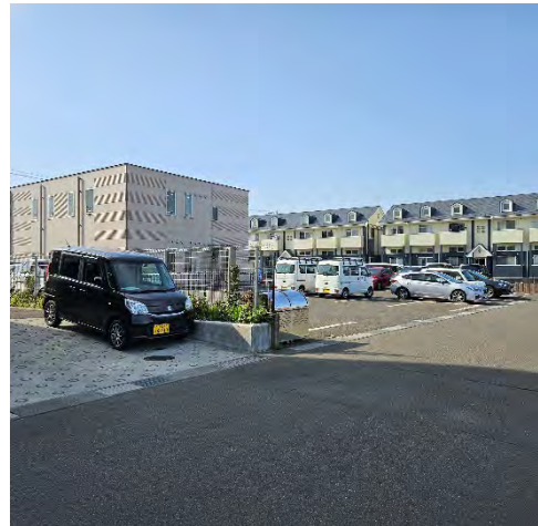
Fig. 42 Photographie de logements de faible hauteur situés en périphérie du site de projet
