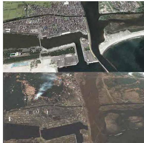
Fig.30 Photographie aérienne avant / après le tsunami d'un quartier côtier
