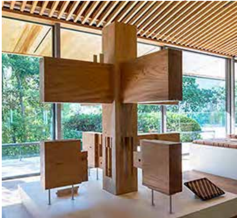
PHOTOGRAPHIE D'ASSEMBLAGE SHIHO-SASHI (Fig. 56)
