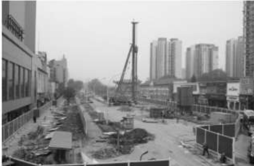
(fig. 17) Photo des démolitions à Quingshan
