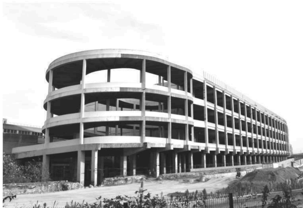
Photographie extérieure entrepôt Ney © Auteur
