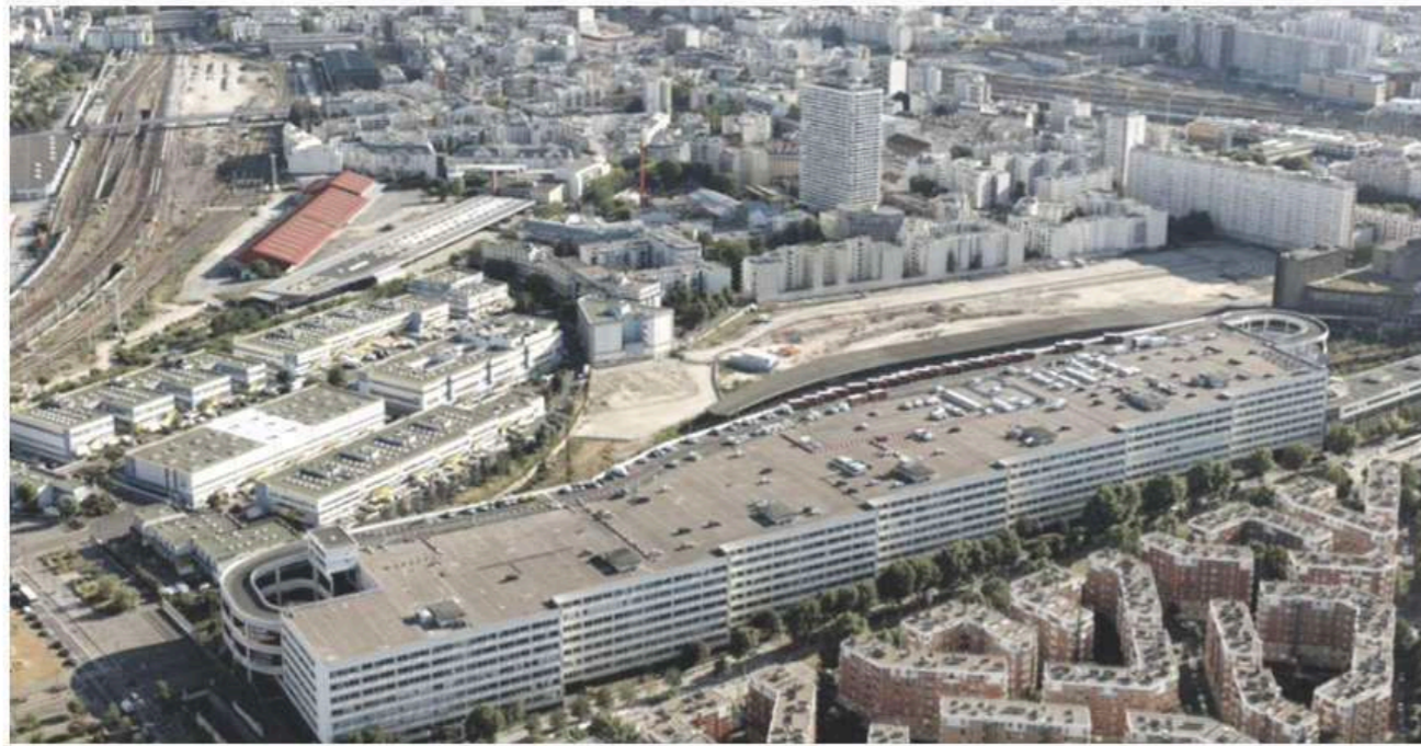
Vue aérienne © Google Earth
