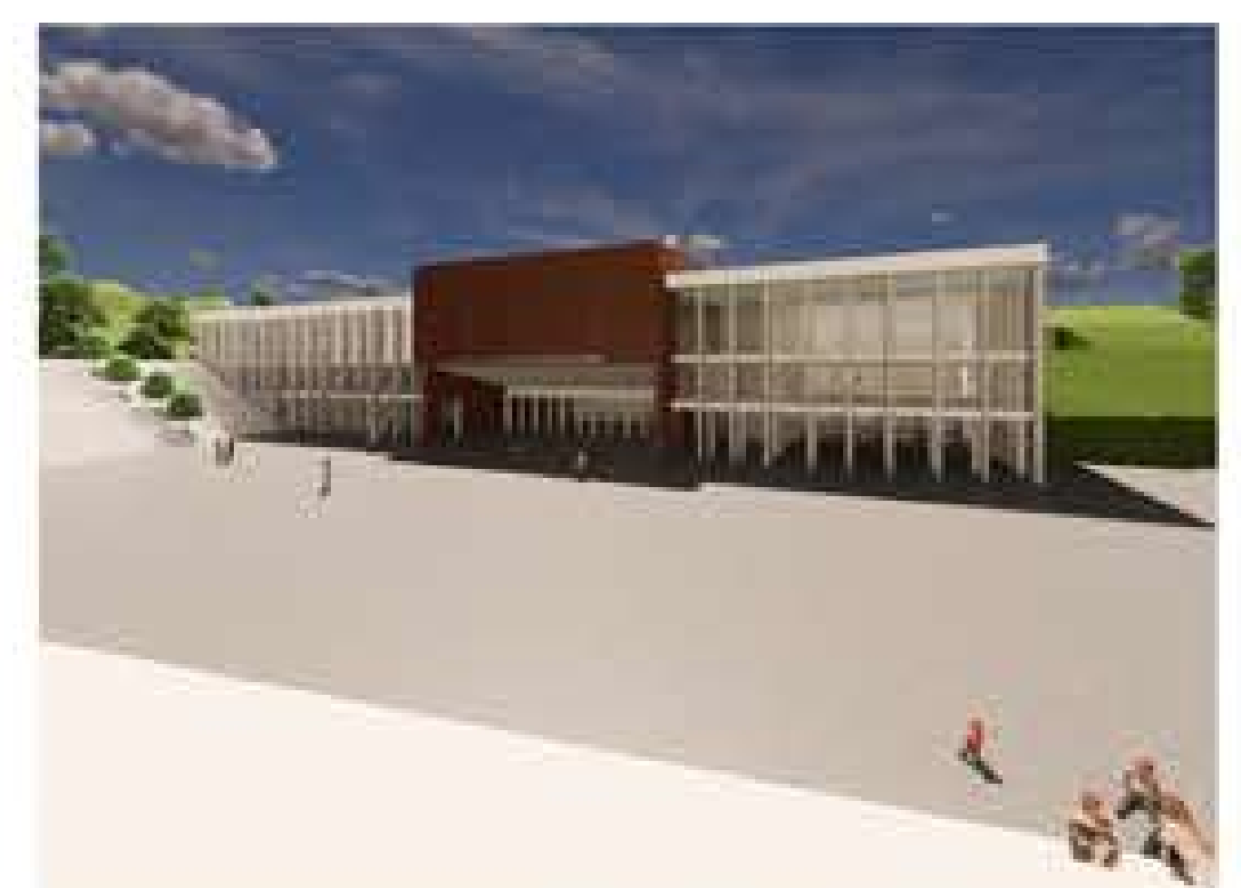
FAÇADE DU PAVILLON DES ASSOCIATIONS DEPUIS LES GRADINS
